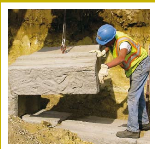
Låsmekanismen gör det enkelt att montera muren. Ett lyftankare underlättar arbetet.
